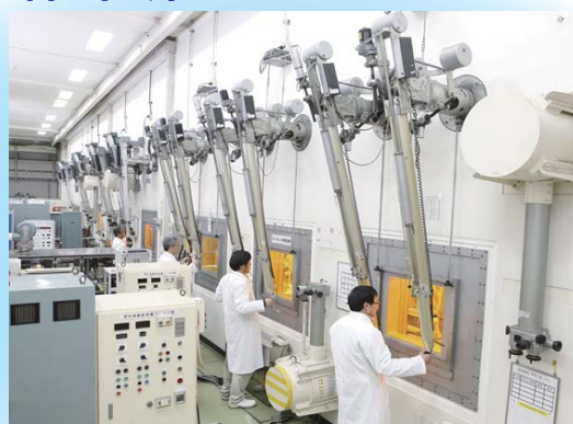
「燃料ホットラボ施設」
