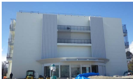
施設管理棟の建設状況（平成30年1月24日）
