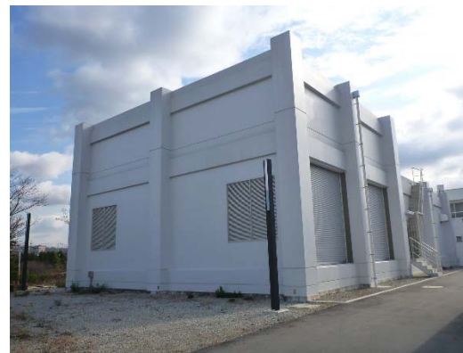
ライフライン強化として 立て替えられた変電所
