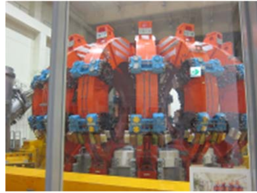
機器収納棟 JT-60
