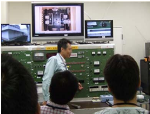
原子炉制御盤の説明
