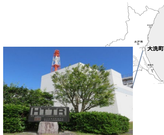
HTTR(高温工学試験研究炉)
